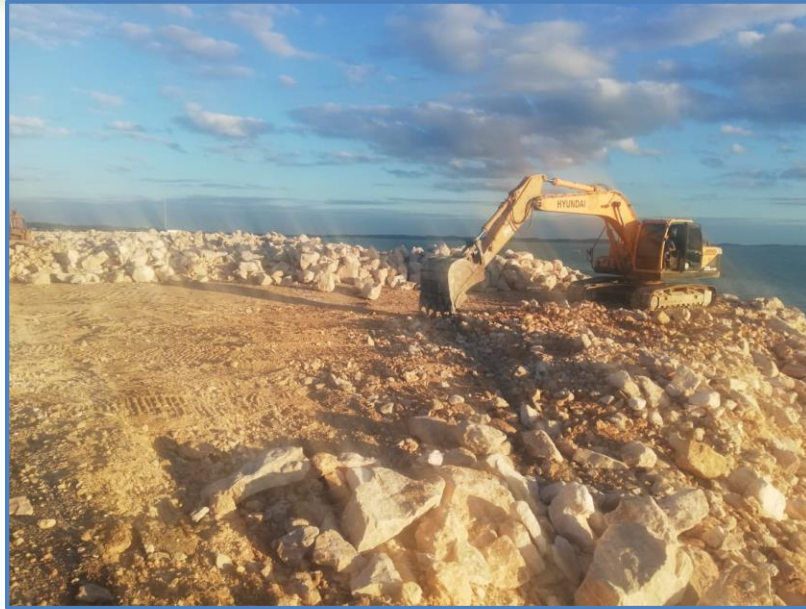
Fig. 24. Vista de la esquina SE (sureste), en donde se visualiza los trabajos de la maquinaria empleada en la reacomodo del material disgregado después de las acciones de suministro y colocación de piedras.
