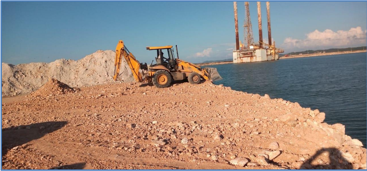
Fig. 32. Vista de la esquina SO (suroeste), en donde se visualiza los trabajos de la maquinaria empleada en la reacomodo del material disgregado después de las acciones de suministro y colocación de piedras.
