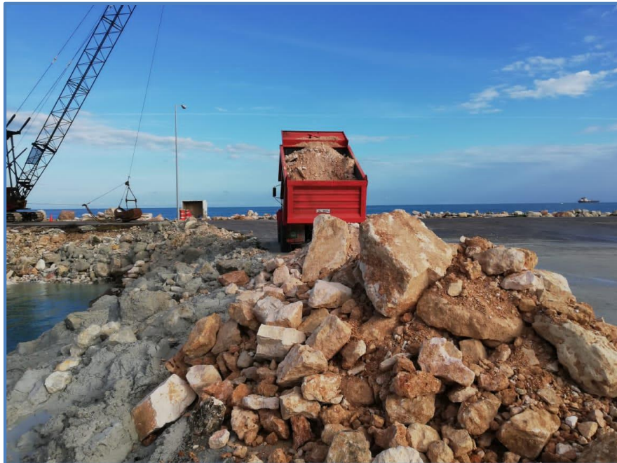
Fig. 35. Camión tipo volteo descargando el material para su colocación en la esquina NO (noroeste), como parte de las acciones de suministro y colocación de piedras.
