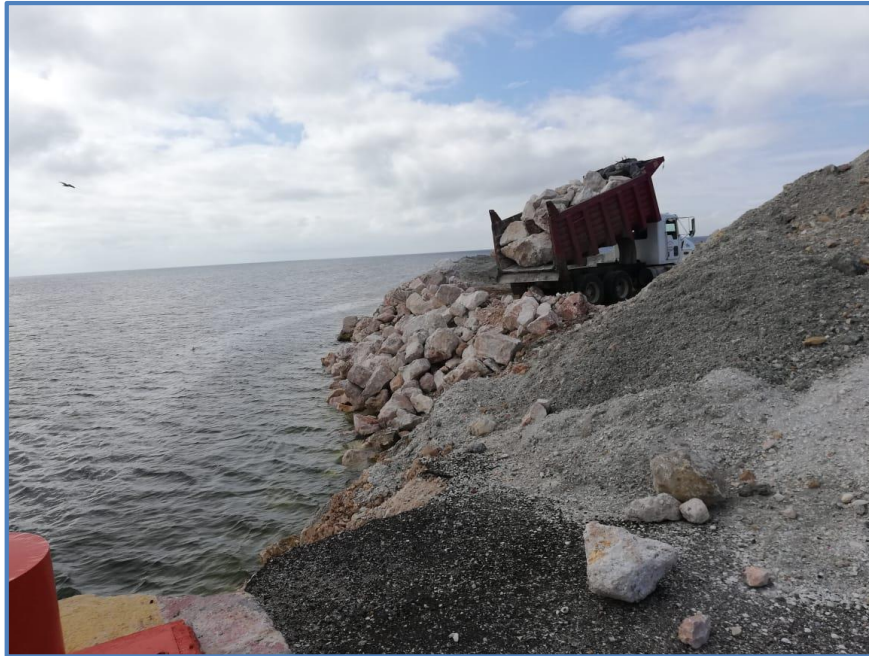
Fig. 30. Vista de la esquina SO (suroeste), en donde se visualizan los avances de las obras y el Camión tipo volteo descargando el material para su colocación, como parte de las acciones de suministro y colocación de piedras.
