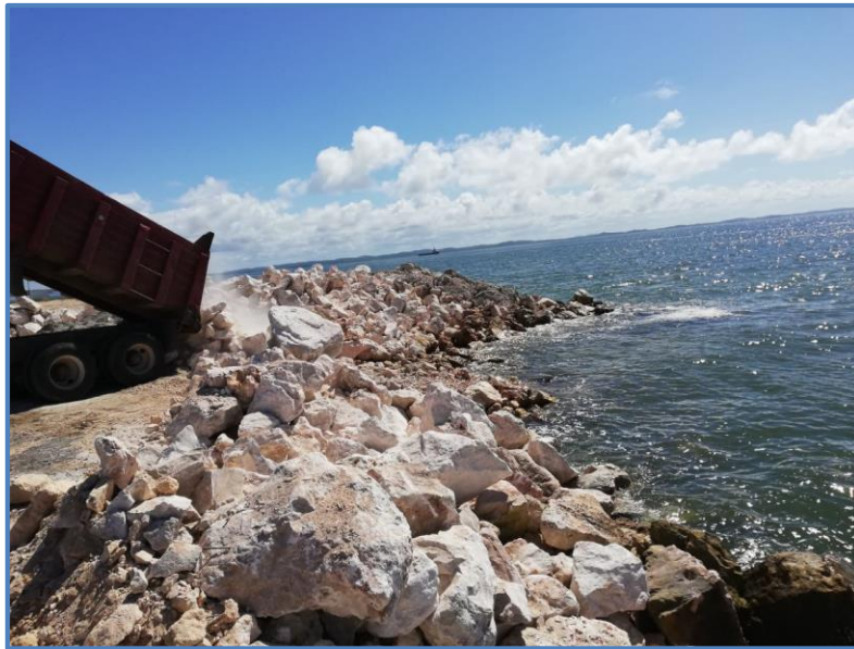
Fig. 22. Vista general de la esquina SE (sureste), en donde se visualizan los avances de las obras y el Camión tipo volteo descargando el material para su colocación, como parte de las acciones de suministro y colocación de piedras.
