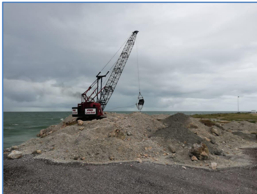
Fig. 21. Vista de la esquina SE (sureste), en donde se visualizan los trabajos de la maquinaria empleada para el reacomodo del material disgregado (piedra de núcleo, arena y/o lodo).
