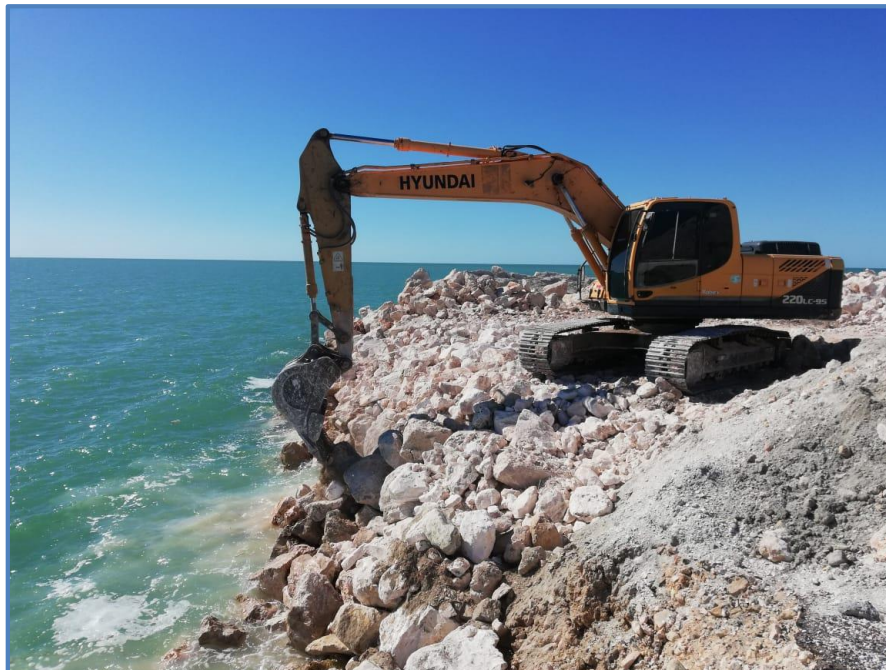
Fig. 29. Vista de la esquina SO (suroeste), en donde se visualizan los trabajos de la maquinaria empleada para el suministro y colocación de piedras.
