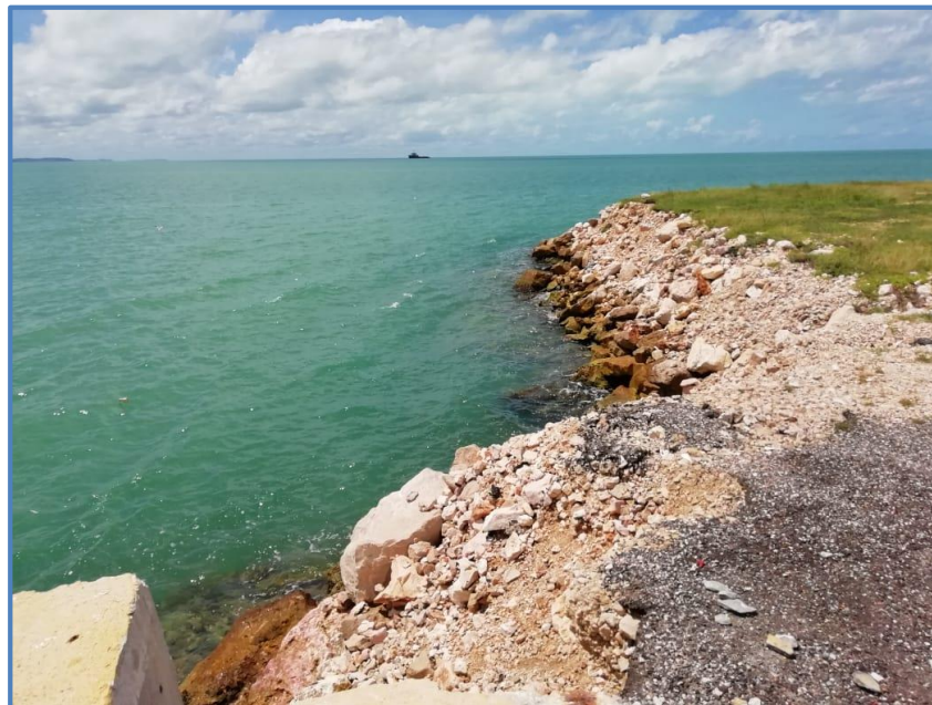
Fig. 15. Vista general de la esquina SE (Sureste) de la Plataforma 8 del P.A.C. Seybaplaya, en donde se visualiza la erosión presentada.
