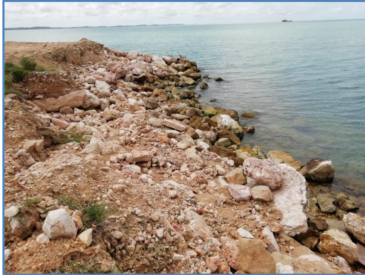
Fig. 18. Vista más cercana de la esquina SO (Suroeste) de la Plataforma 8 del P.A.C. Seybaplaya, en donde se visualiza la erosión que presenta.
