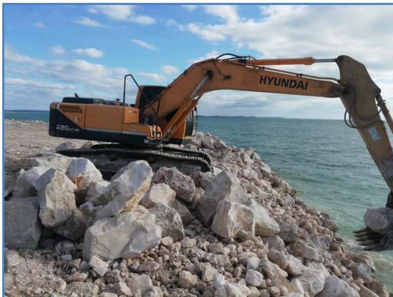
Fig. 23. Vista de la esquina SE (sureste), en donde se visualizan los trabajos de la maquinaria empleada para el suministro y colocación de piedras.
