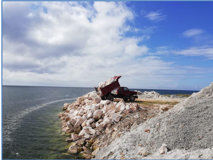
Fig. 28. Vista de la esquina SO (suroeste), en donde se visualizan los avances de las obras y el Camión tipo volteo descargando el material para su colocación, como parte de las acciones de suministro y colocación de piedras.
