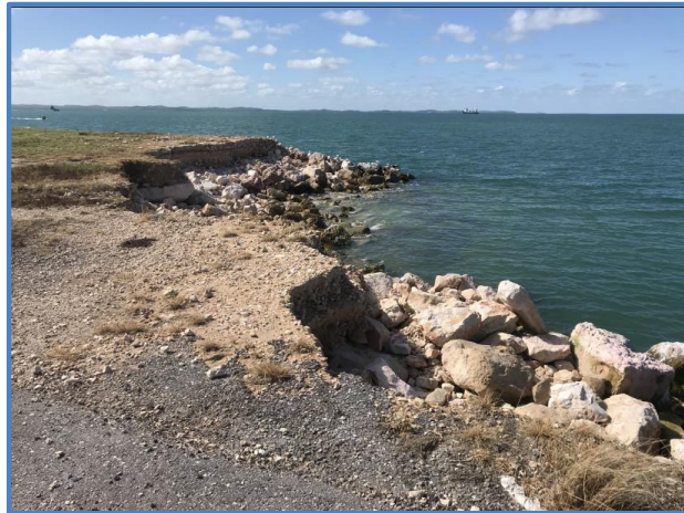
Fig. 7. Daños que se presentaban en la esquina SO (suroeste) de la plataforma 8.
