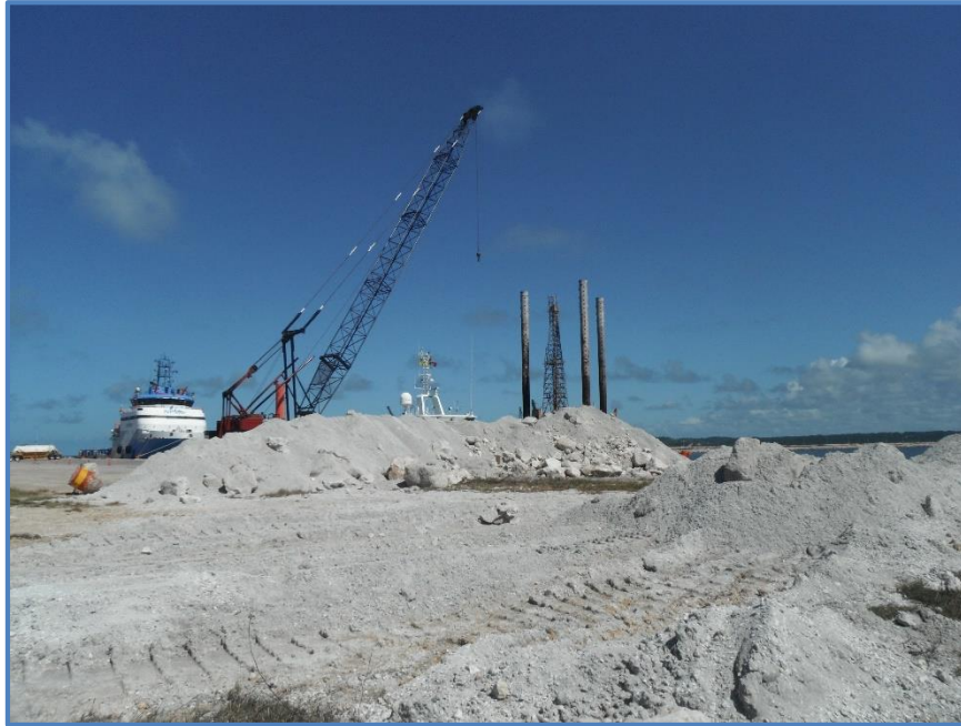
Fig. 20. Vista general de la esquina SE (sureste), en donde se visualizan los avances de reacomodo del material disgregado (piedra de núcleo, arena y/o lodo) del producto de la erosión
