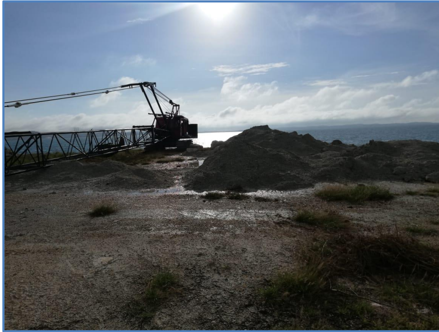
Fig. 26. Vista de la esquina SO (suroeste), en donde se visualizan los trabajos de la maquinaria empleada para el reacomodo del material disgregado (piedra de núcleo, arena y/o lodo).
