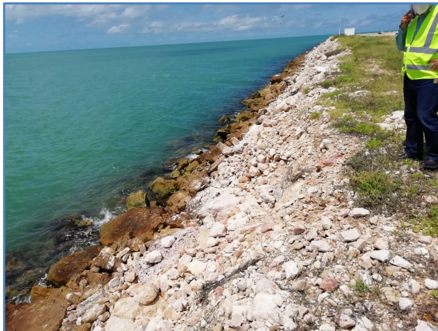
Fig. 16. Vista general del lado sur de la Plataforma 8 del P.A.C. Seybaplaya, en donde se visualiza la erosión presentada.
