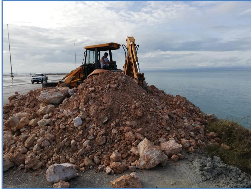
Fig. 34. Vista general de la esquina NO (noroeste), en donde se visualizan los avances de suministro y colocación de piedra para conformar el Talud.
