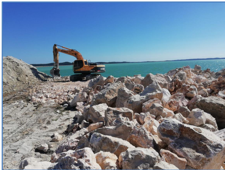
Fig. 31. Vista de la esquina SO (suroeste), en donde se visualizan los trabajos de la maquinaria empleada para el suministro y colocación de piedras.
